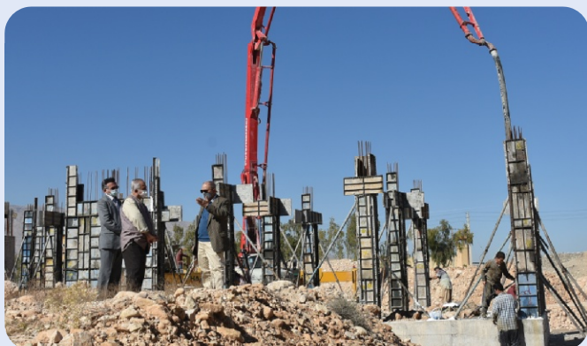
عملیات بتن ریزی ستون های خوابگاه خیر ساز پردیس دانشگاه سلمان فارسی کازرون - 18 دی 1400
