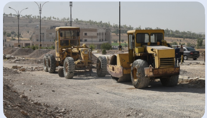
آغاز عملیات تسطیح و بیس کوبی راه‌ها و مسیرهای دسترسی پردیس دانشگاه - تیرماه 1401
